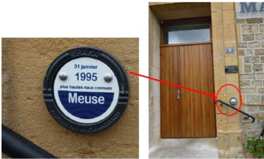
Repères de crues, Mairie de Warcq (08)
